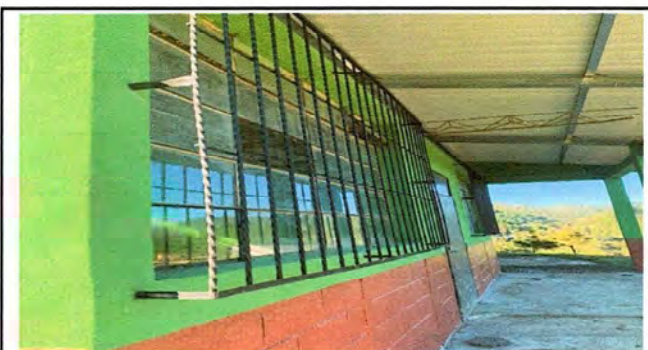
Foto 3: FOTOGRAFIA DESPUES DE LA FINALIZACIÓN DE LA INSTALACIÓN DE LOS BALCONES DEL CENTRO EDUCATIVO.
