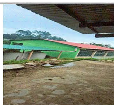
Foto 6: VISTA LATERAL DESPUES DE HABER FINALIZADO CON LA PINTURA DEL CENTRO EDUCATIVO.
