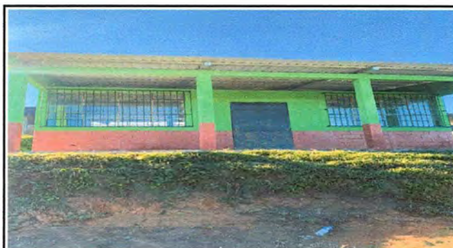
Foto 4: FOTOGRAFIA DESPUES DE LA FINALIZACIÓN DE LA CONSTRUCCIÓN DEL ESTABLECIMIENTO.
