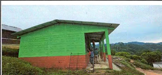
Foto 1: VISTA LATERAL DEL TECHO Y DE LA ESTRUCTURA METALICA DEL ESTABLECIMIENTO.
