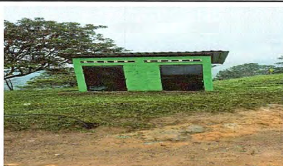
Foto 2: FINALIZACIÓN DE LA CONSTRUCCIÓN DE LOS BAÑOS DEL ESTABLECIMIENTO.
