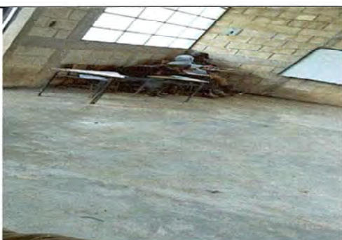
Foto 5: FOTOGRAFIA DESPUES DE HABER FINALIZADO CON LA COLOCACIÓN DEL PISO DEL CENTRO EDUCATIVO.
